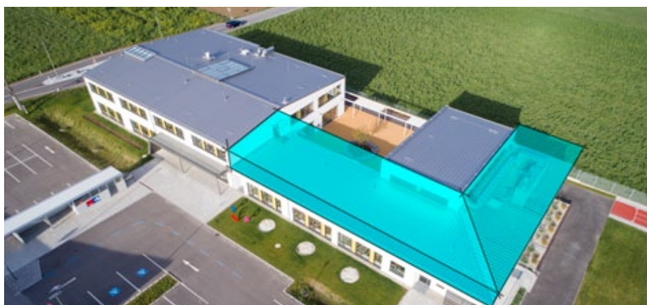
Hier ist sehr gut der Bereich ersichtlich, der für den Betrieb des Kindergartens aufgestockt wird.
