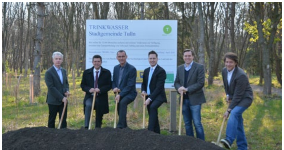
Spatenstich in Tulln Versorgungsleitung Tulbing
